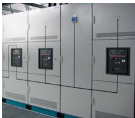
Die TSK Schaltanlage 4000A mit integriertem externen Bypass-System und separatem Bypass für die EUE (Elektronische Umschalt Einrichtung) erhöht die Verfügbarkeit des gesamten Systems.
