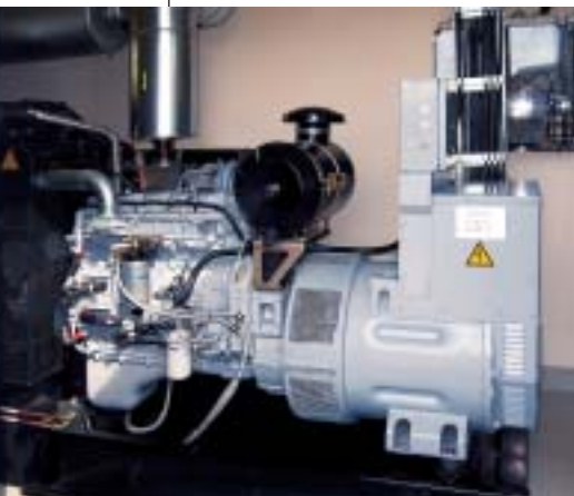
Netzersatzanlage 200kVA
